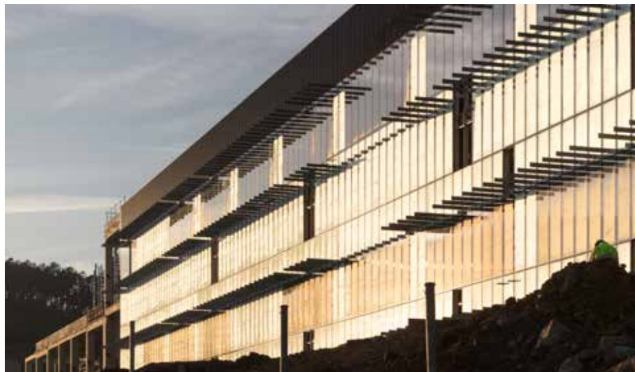
Foto: Planta de producción farmacéutica en construcción en Derio (Bizkaia)
